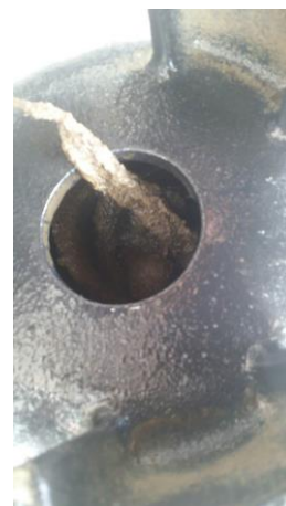
ยกป้้ม Return ขึ้นมาตรวจสอบ พบขยะติดใบพัด
