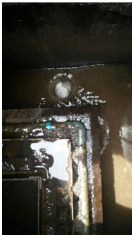
ภายในบ่อดกตะกอน 2
