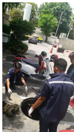
ยกป้้ม Return ขึ้นมาตรวจสอบ พบขยะติดใบพัด
