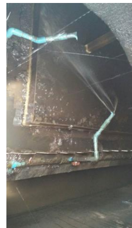
ภายในบ่อดกตะกอน 2
